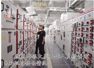
图 为邯银大厦地下双路高压市电配电机房
